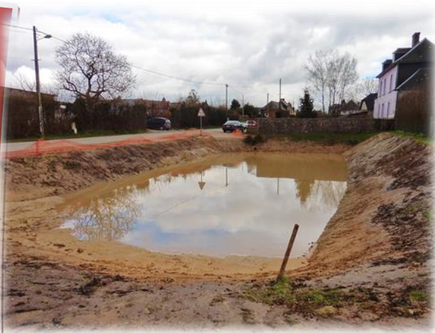
7 - Réfection des berges en pente douce pour accueillir une faune et une flore diversifiées
