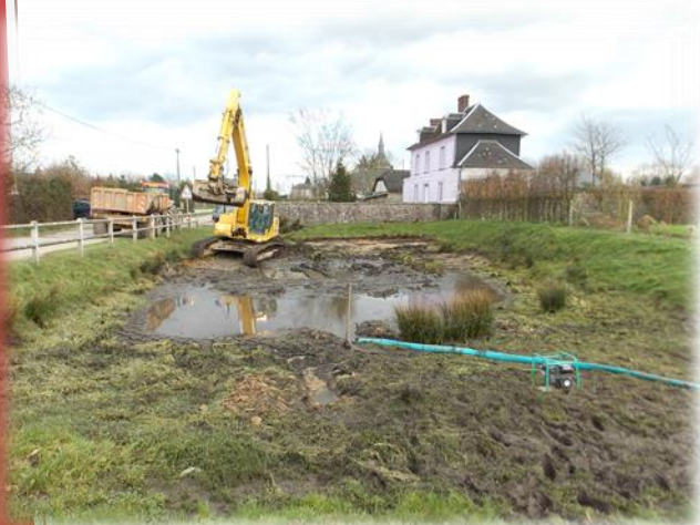
3 - Pompage de l'eau de la mare renvoyée dans le débit de fuite
