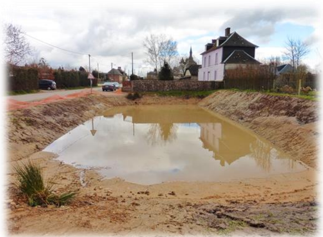
8 - Le volume de la mare est désormais de 600 m 3 soit trois fois plus que son volume initial
