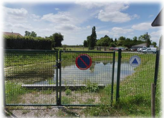
10 - Création d'une aire d'aspiration incendie
