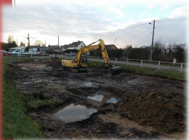
5 - Suite des travaux de désenvasement et mise en sauvegarde de la faune aquatique
