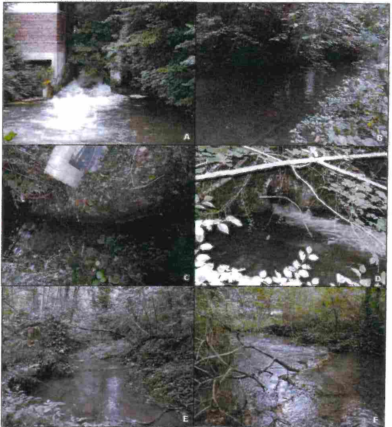
Figure 2. Vues successives de l'ouvrage transversal attaché à l'ancien Moulin de Senarpont (image « A », depuis l'aval), de son bief et ses dispositifs de surverse actuels (images « B », « C » et « D ») puis des milieux adjacents se développant désormais en pied de digue et en partie est du site (images « E » et « F ») - clichés Biotec, octobre 2012
