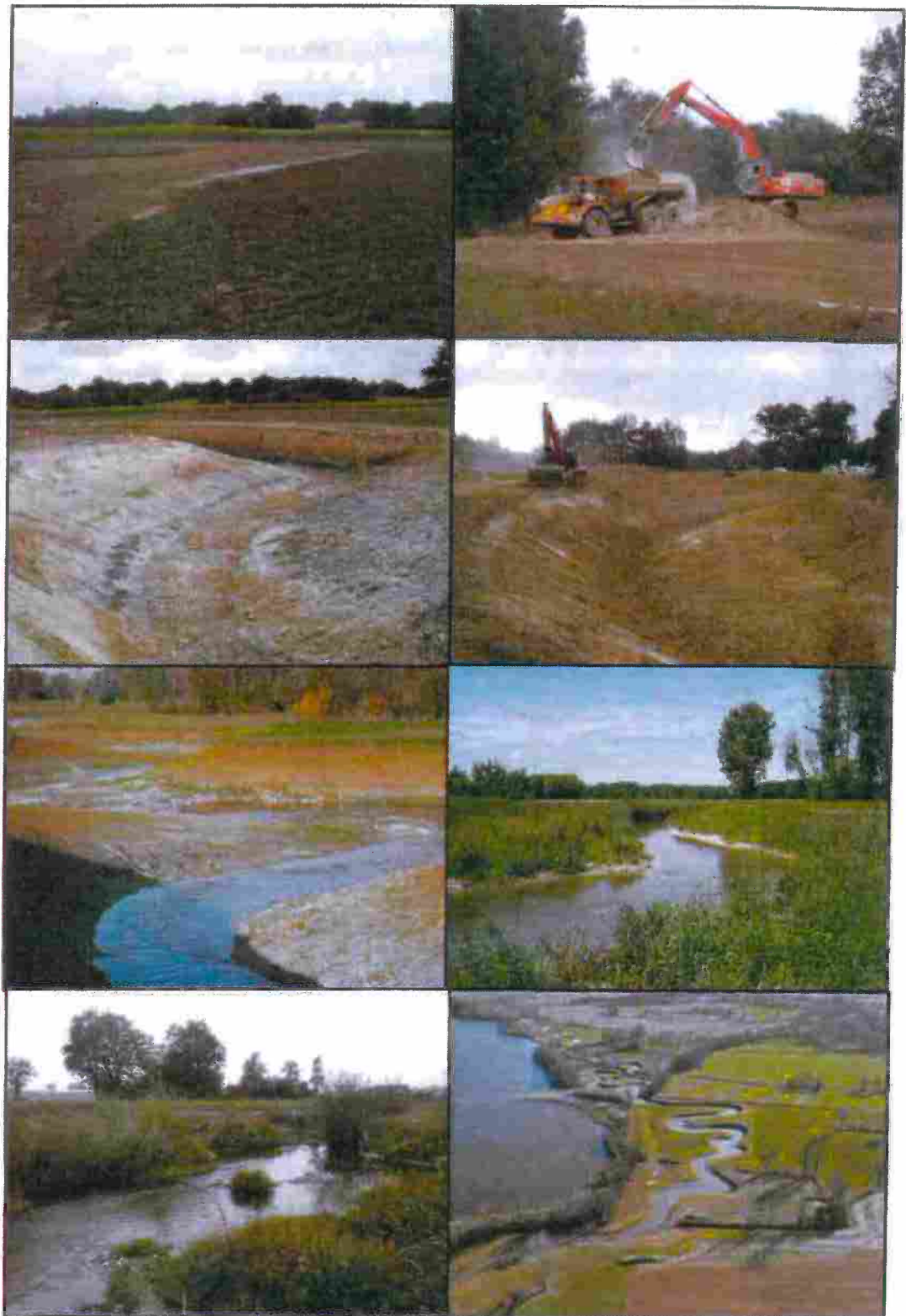
Figure 5. Illustrations successives de l'opération de création d'un nouveau lit de la Veyle au droit du plan d'eau de la gravière de St-Denis-les-Bourg (01) (conception et maîtrise d'œuvre : Biotec). Chantier de 2009.
