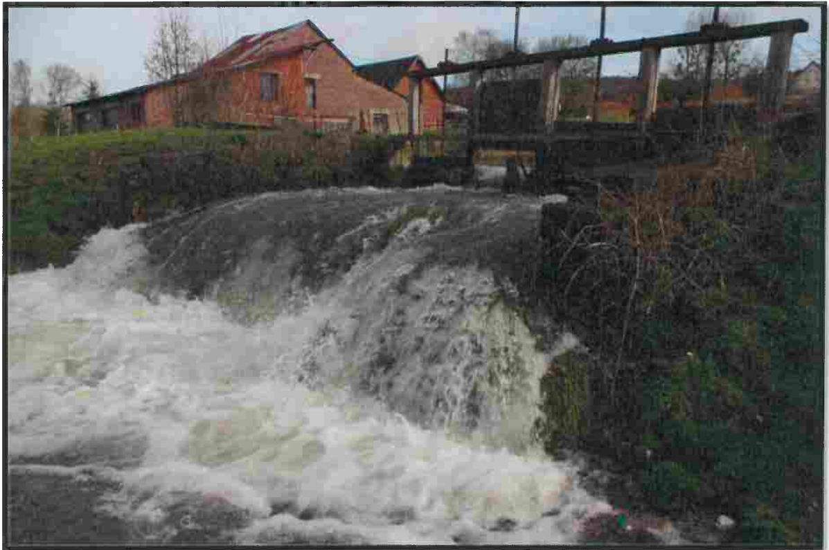
Photo n° 5 : Chute d'eau présentant des difficultés de franchissement pour les poissons migrateurs
