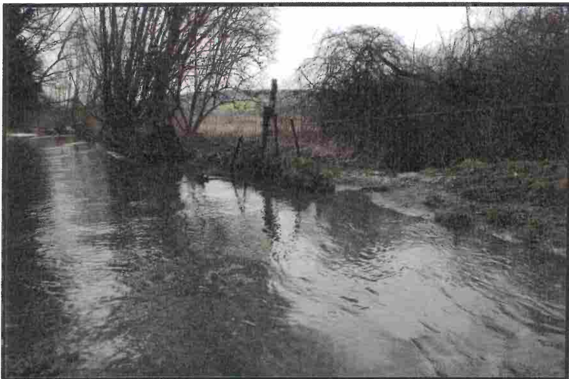
Photo n° 2 : Présence de multiples brèches dans le bief de l'ouvrage
