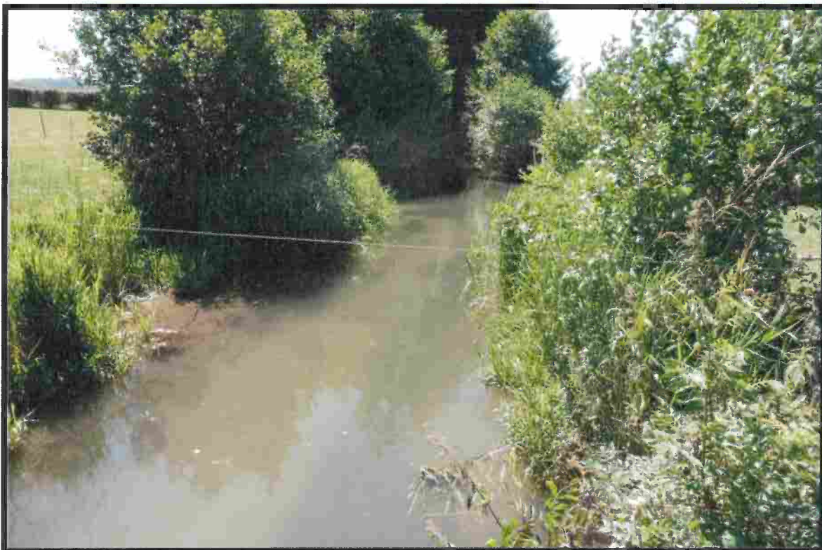
Photo n °1 : Bief envasé du moulin de l'abreuvoir
