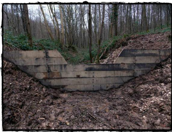
*Des seuils implantés (pieux de 2m en aérien et 2m en profondeur en chêne de dimension 15x15cm avec des planches de 5cm d'épaisseur) en milieu forestier dans une cavée*
