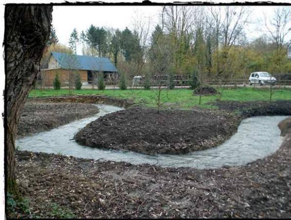
*Le bras de rivière serpente sur 70 mètres pour rattraper la hauteur de chute de l'ouvrage*
