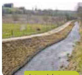
Juste après les travaux
