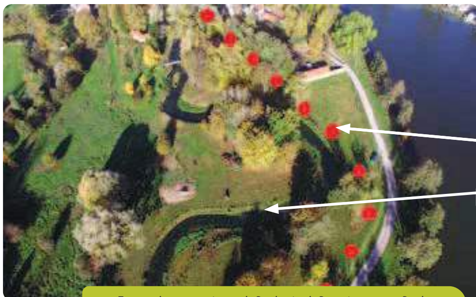
Travaux de renaturation sur la Bresle, site de Bouvaincourt-sur-Bresle
