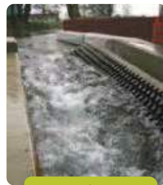
Passage à ralentisseurs, ouvrage de Beauchamps
